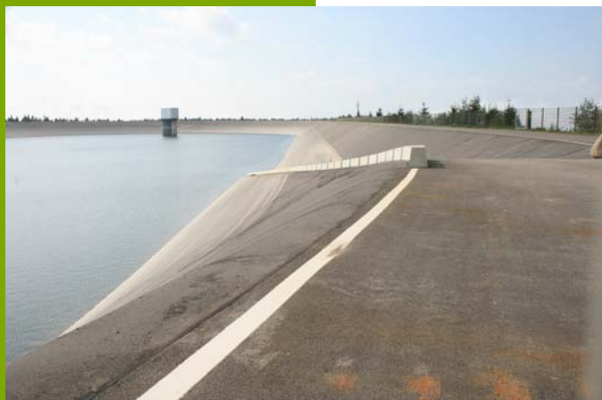
Industriespeicher Hornbergbecken I
